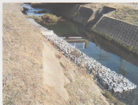
図3 施工中の様子（2004. 2. 19）
